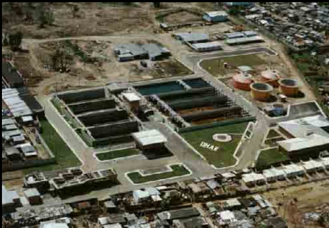
Figura 2. Vista aérea da estação de tratamento de esgoto ETE São João – Navegantes, identificando os locais das coletas das amostras, 1: afluente (esgoto bruto) e 2: efluente (esgoto tratado). 3: tanques de aeração. ( http://www2.portoalegre.rs.gov.br/dmae/default.php ).
